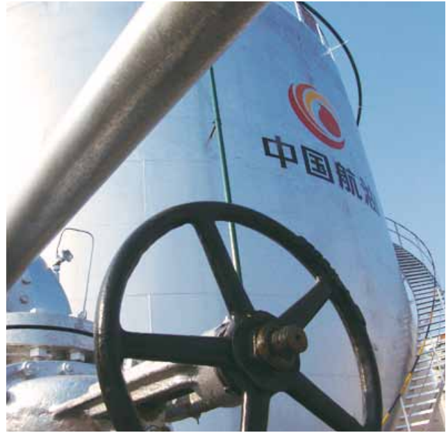
Storage facilities in China 在中国的储罐设施
